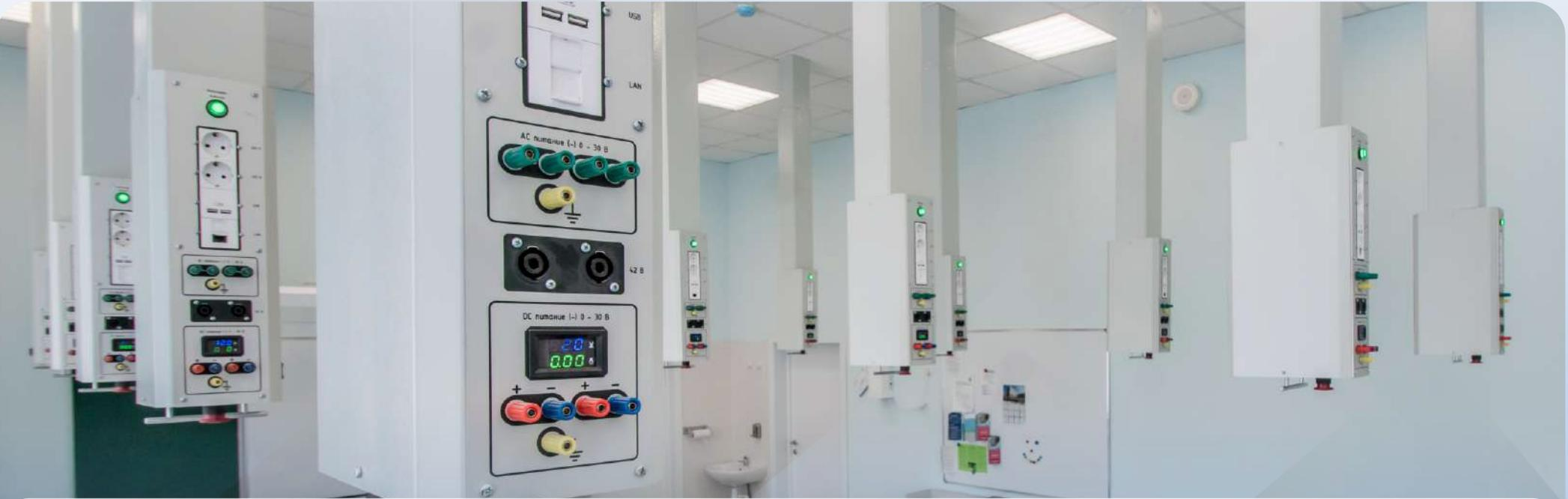
Система электроснабжения потолочная применяются для обеспечения электропитанием (220В; пониженным переменным и постоянным напряжением) оборудования, электрических схем, цифровых лабораторий, робототехники, станков, подзарядки ноутбуков и для других целей, при проведении демонстрационных опытов, фронтальных и лабораторных работ, практикумов, кружковых и факультативных занятий.
