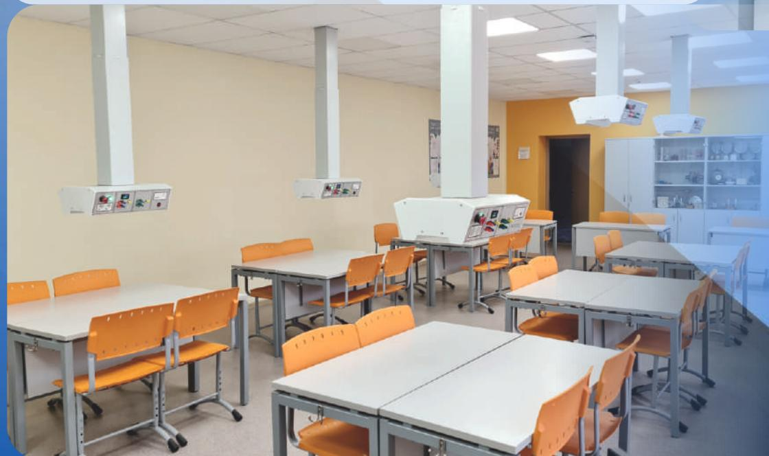
Система электроснабжения потолочная обеспечивает рабочие места электроэнергией, водой, сжатым воздухом, освещением. Использование потолочной системы подачи инженерных ресурсов значительно упрощает проектирование помещения и согласование прокладки коммуникаций.
